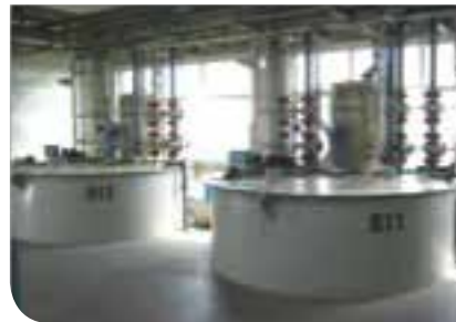
Abwasserbehandlungsanlage Galvanik
